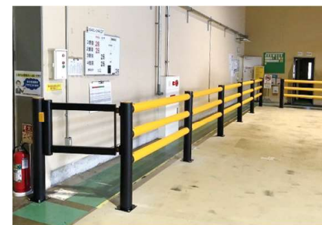
防護柵設置工事
