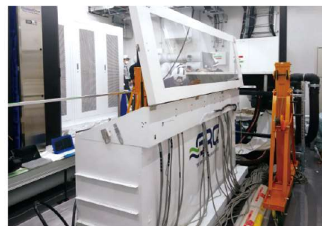
液浸冷却装置配線工事
