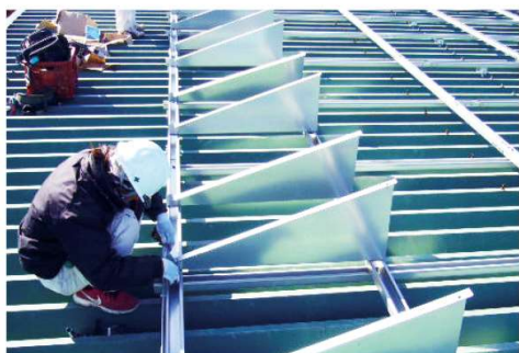
ソーラーパネル設置工事
