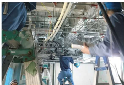
ネットワーク設備配線工事
