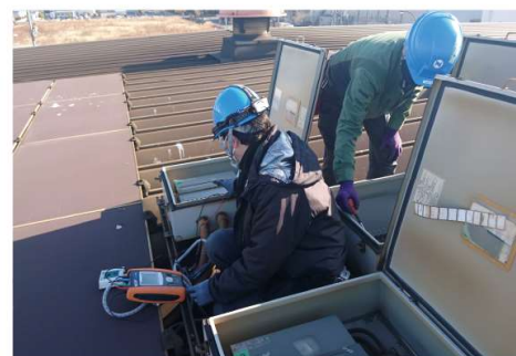
電気点検作業
