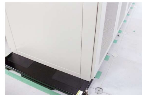
免震装置設置工事
