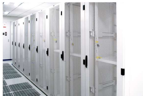
サーバーラック設置工事
