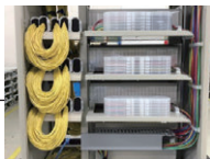
背面側でUターン配線。コード余長をクロス無く処理が可能。
