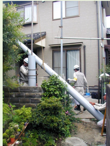
⑤ 上管吊り上げ
